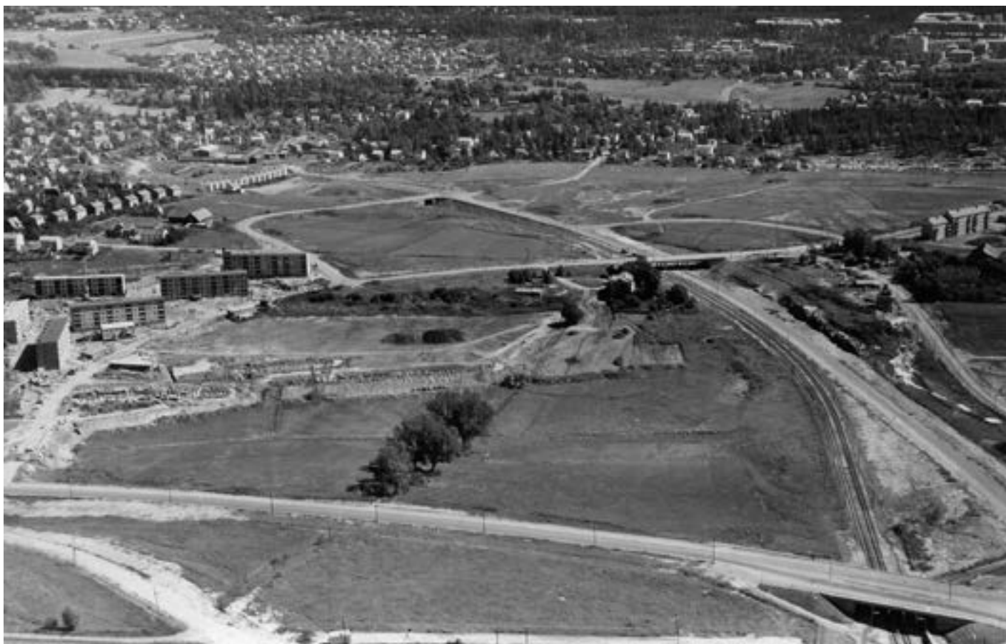
Manglerud-området under utbygging til variert bebyggelse, industri, senter og mye annet, for et folketall så stort som flere norske byer. Nyoppførte blokker ved Emil Korsmos vei og Plogveien til venstre i bildet, men vi ser at fortsatt gjenstod mye å bygge, blant annet barneskole, senter og politistasjon i kjerneområdet rundt banestasjonen og broen over Ringveien (til høyre for blokkene i bildet). Trærne i forgrunnen stod i mange år som del av barndommens uutbyggede «prærielandskap» i et gjennomregulert og planlagt drabantbyområde. Ringveien og Lambertseterbanen vises som skrå linjer fra nedre høyre hjørne i bildet. Fotograf: Widerøes Flyveselskap/J. Kruse. År. 1958. A-20027/Ua/0013/001.
